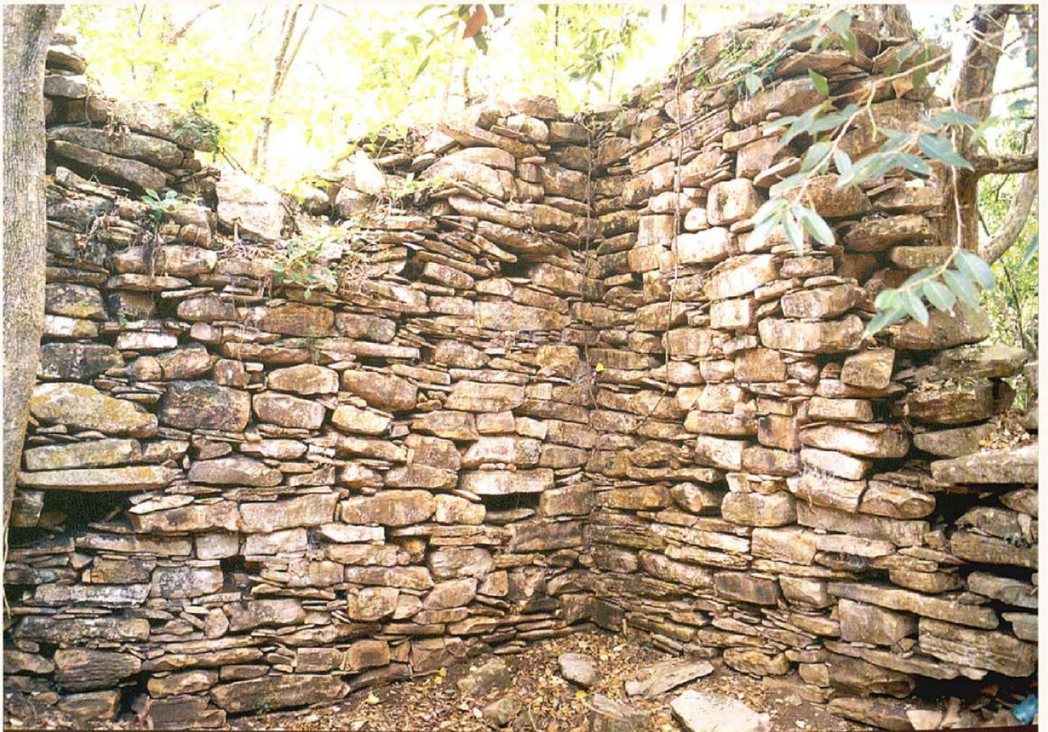
Esquina de la estructura de la misión, en la que se muestra la habilidad de los alarifes que diseñaron y construyeron este mueble, utilizando los recursos naturales que les ofrecía el entorno
