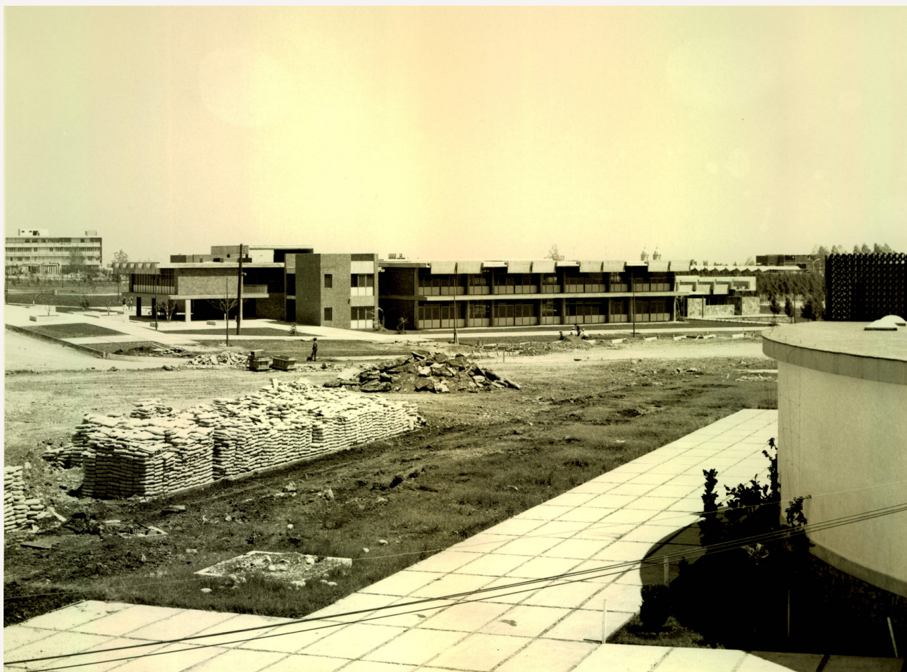
Fase constructiva de la Facultad de Comercio y Administración
